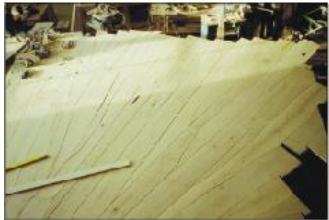
Fugenverlauf der Dielen im Detail
