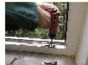
4) Rahmentteile einbauen und Beschlag fetten
