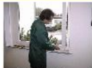
3) Flügel eingehängen und einstellen
