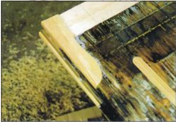
Reparatur einer Füllungskante
