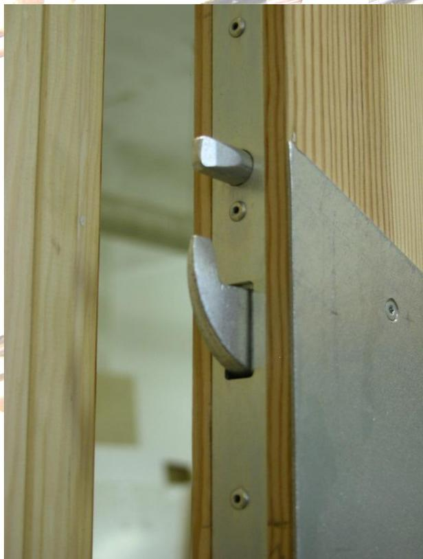
**Integrierte Türschlösser, sogenannte Mehrfachverriegelungen, werden in der Türkante versteckt eingebaut und besitzen verschiedenartige Verschlussnocken.**
