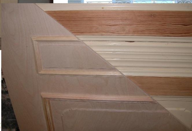
Türverstärkungen aus Blech oder Multiplexplatten dienen der Stabilisierung der Türblätter und sichern die Füllungen. Aufgesetzte Profile erhalten die Altbauoptik.
